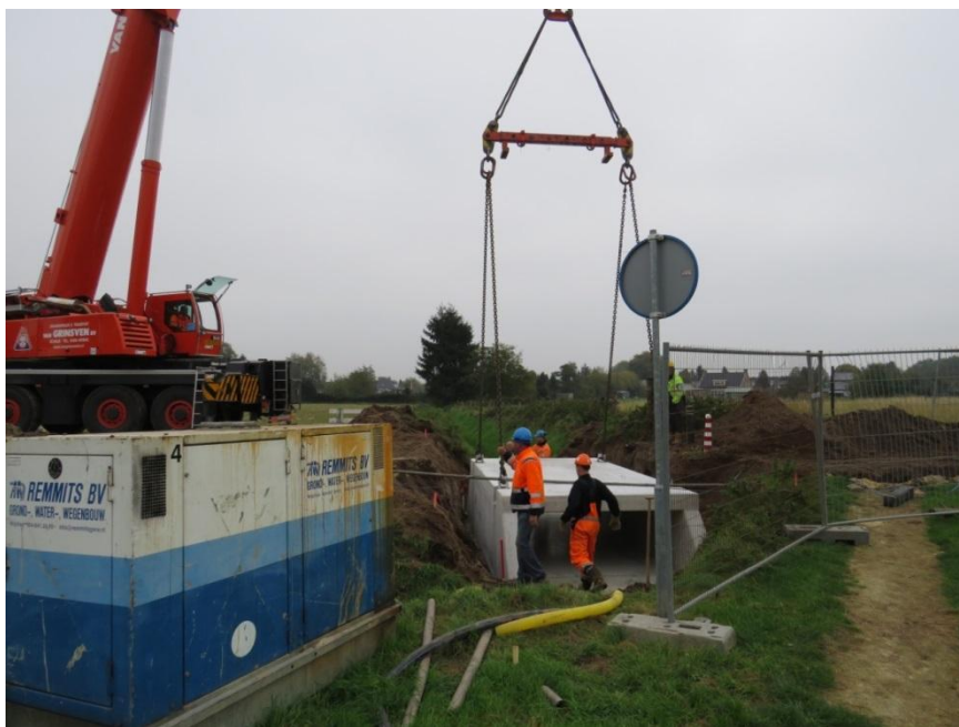
Afbeelding 13 Plaatsing nieuwe duiker achter het BBB Zesweg (2017).
