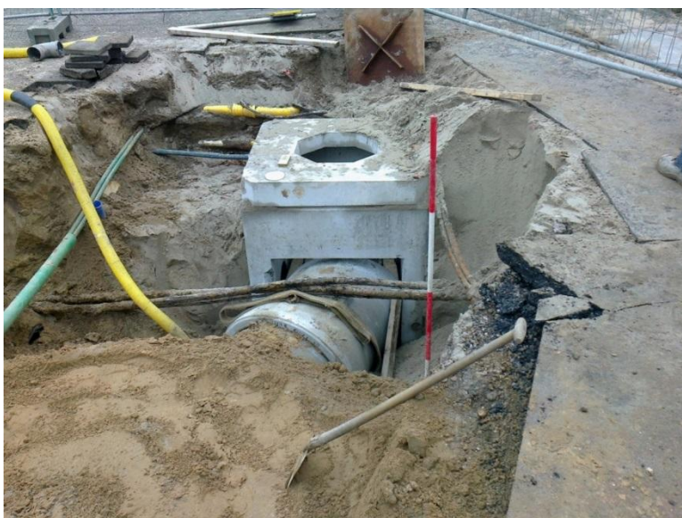
Afbeelding 5 Riolwerkzaamheden in de Kasteellaan tussen de Bronckhorstlaan en de Ringlaan (2013).
