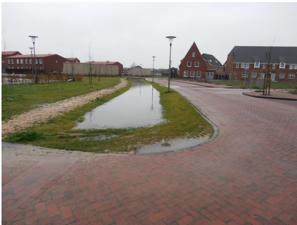
Afbeelding 7 Wadi langs de Marskramer (Hurlingsedam fase 1) na een flinke regenbui (2016).
