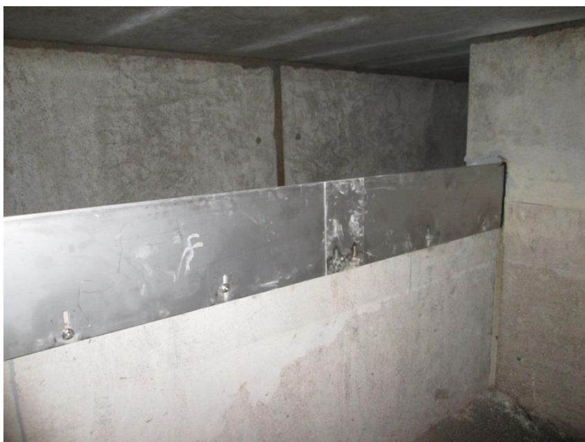
Afbeelding 8 Overstortmes in het bergbezinkbassin langs de Meerdreef (2015).
