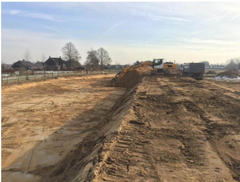
Afbeelding 12 Ontgravingswerkzaamheden t.b.v. de verruiming van de A-watergang achter het bergbezinkbassin in de Zesweg fase 1 (2017).
