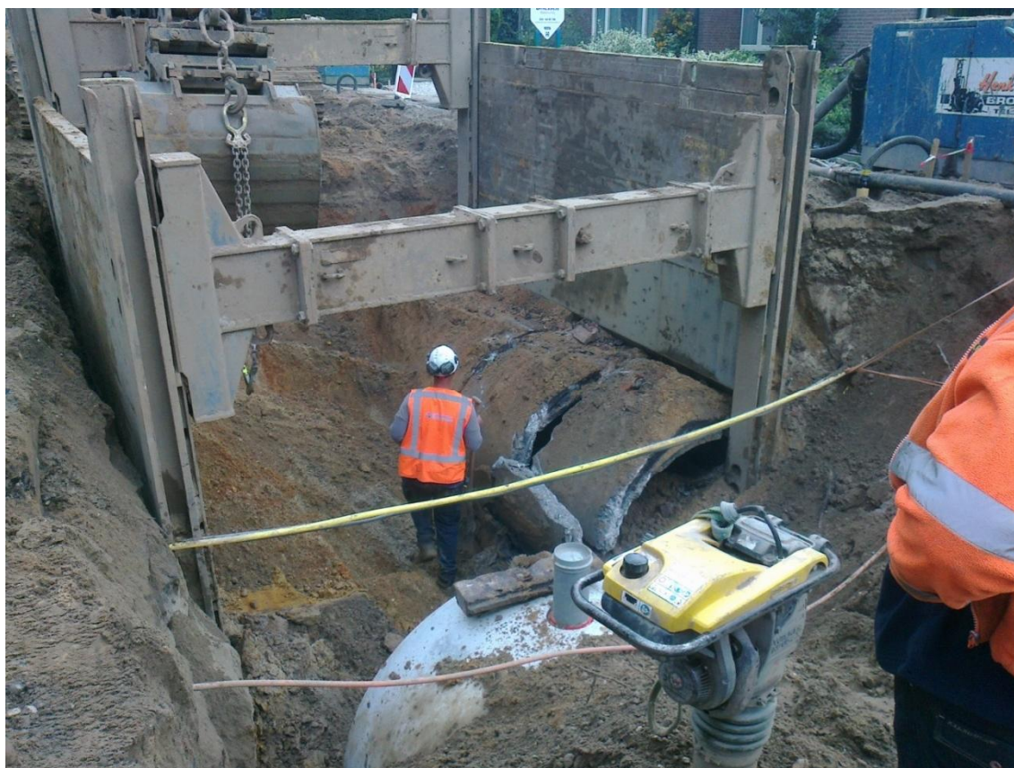
Afbeelding 1 Vervanging van het transportriool in de Oosterweg tussen de Mr. Van Coothlaan en De Steenoven (2014).
