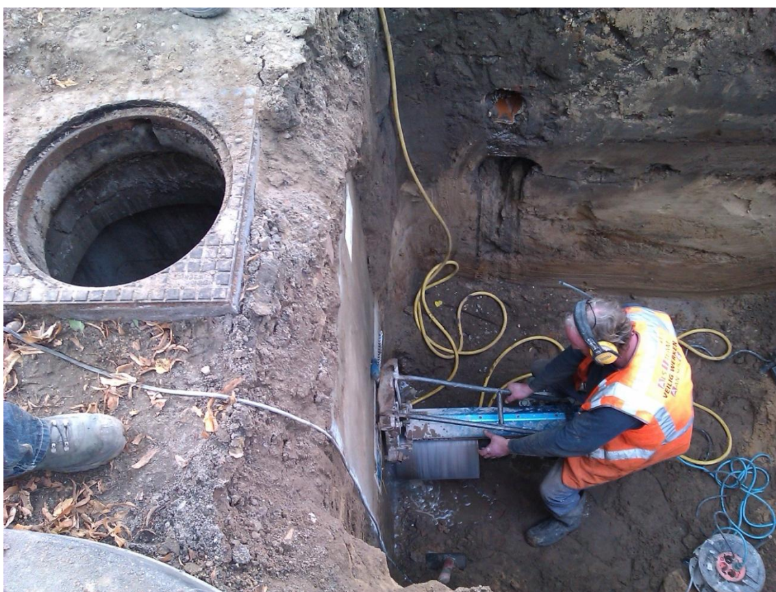
Afbeelding 11 Riolvervanging in de Oud Ravensteinseweg (2012).
